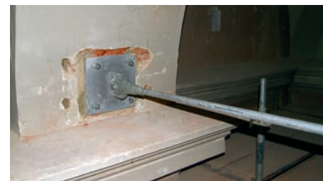
Horizontalabspannung der Gewölbeoberfläche oberhalb der Pfeilergesimse
