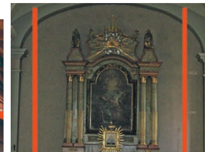
Vertikalabspannung des Stahlrahmens in der Altarwand
