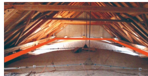
Herstellung eines Stahlrahmens zur Mauerwerksaussteifung im Dachraum
