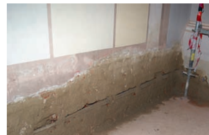
Instandsetzung des kaputten Innenputzes sowie Erneuerung der elektrischen Leitungen und des Innenanstriches.
