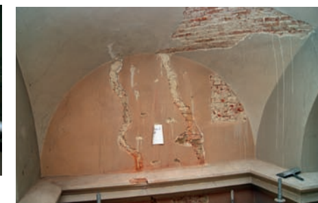
Sanierung der Risse in Mauerwerk und Gewölbeschalen
