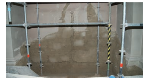
Instandsetzung des kaputten Innenputzes sowie Erneuerung der elektrischen Leitungen und des Innenanstriches.
