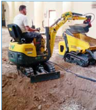
Mit Baggern wurde das feuchte Bodenmaterial entfernt.
