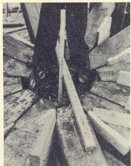
Am höchsten Punkt über der Kuppel treffen die neuen Balken sternförmig zusammen, die Mitte wird mit Beton ausgefüllt.
