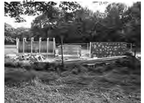
Renovierung der Mauer 2010
