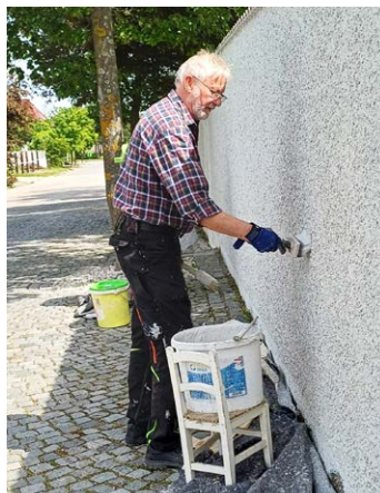
Sanierung der Außenmauer des Pfarrhofs
