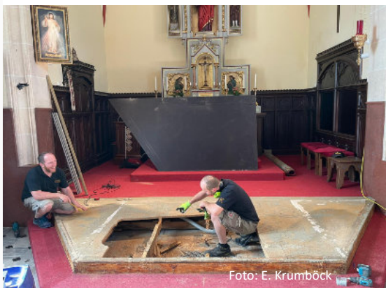
Die Fa. Karlhofer sorgte dafür, dass die Altarstufen wieder stabil sind.
