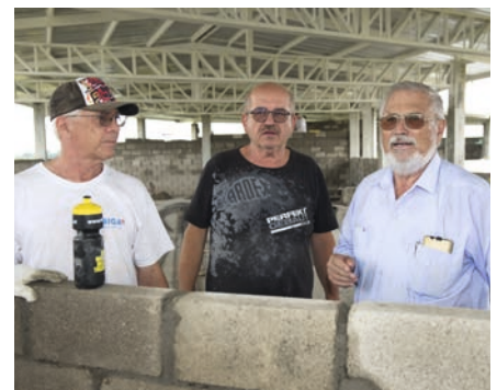
P. Helmut (rechts) beim Besuch der Baustelle im Sommer 2023 mit Baumeister Erhard Halmer und DI Heinz Cotutsca.
