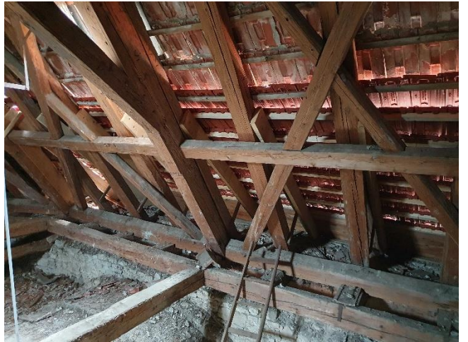
Alle Sparren werden durch Beinagelung verstärkt (Foto: Josef Winna)
