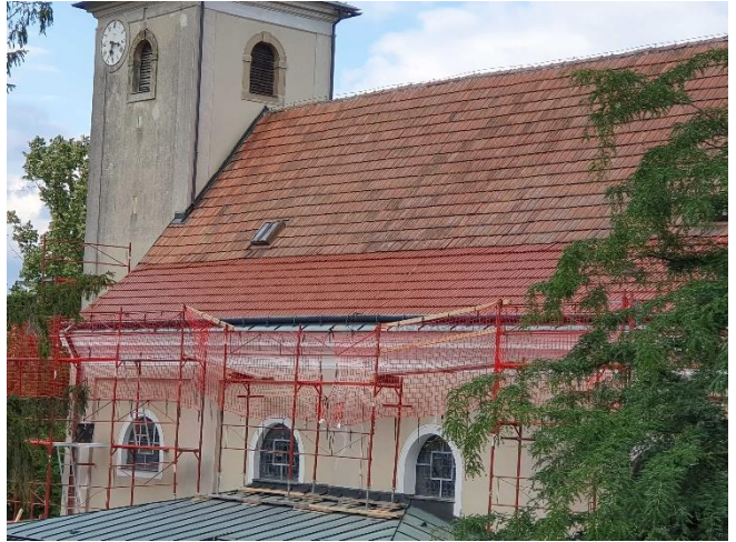
Die Arbeiten haben begonnen, ein Teil ist bereits neu eingedeckt (Foto: Josef Winna)
