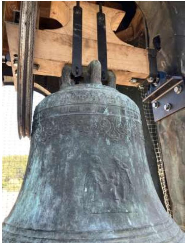
Gleichzeitig damit wurden auch die Antriebe der drei Glocken erneuert. Für die historische Glocke wurde das vorhandene Metalljoch durch ein Eichenholzjoch ersetzt. Ein neu montierter Rundballenknöppel soll die Lebenszeit der Glocke verlängern und die Schwingungen im Glockenturm reduzieren. Dies ergibt mit schonenderem Schlag auch hörbar tiefere Töne.
