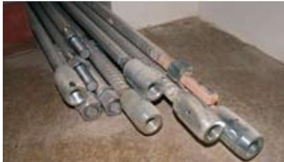
*In jedem Turmeck werden Stahlstangen vom Fundament bis zur Zwiebel eingemauert.*
