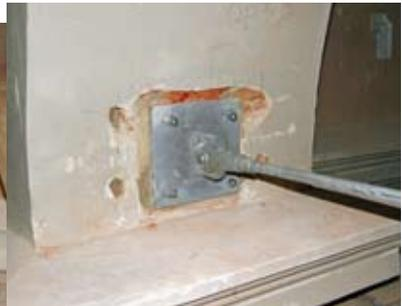
*Mehrere Tonnen Stahl werden eingebaut, verschraubt und gespannt, damit das Gewölbe sicher hält.*
