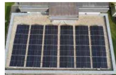
Blick auf das Dach
